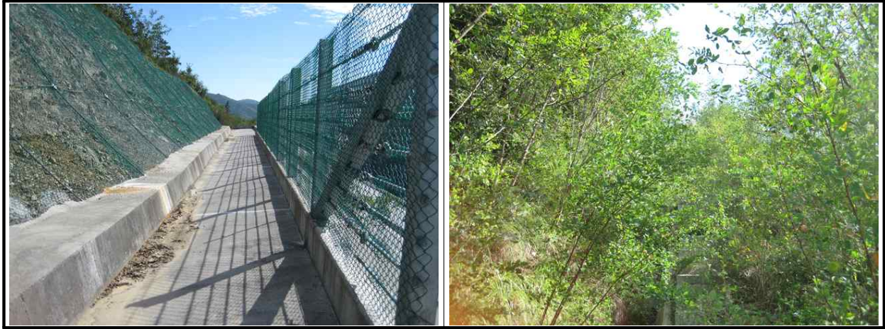
【그림 24.3.3】 배수시설 전경
