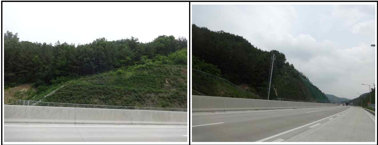
【그림 24.3.1】 상부자연사면 전경
